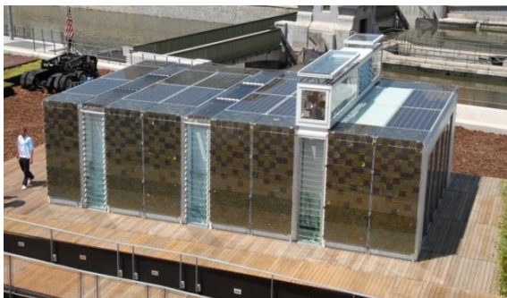
Abbildung 1: Fotoaufnahme des home + mit den PVT-Kollektoren auf dem Dach, Quelle: HfT Stuttgart
