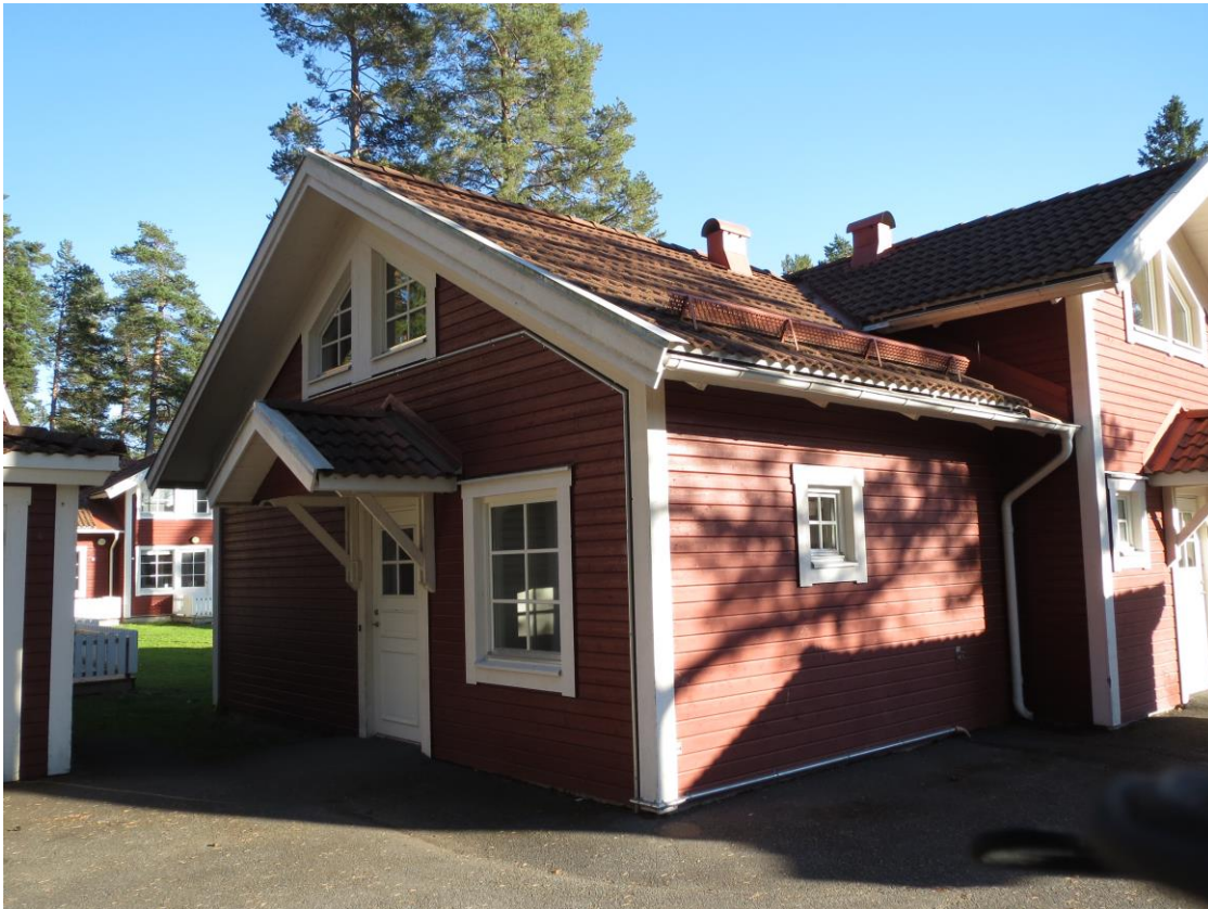
1 Dieses Haus besteht aus 3 Wohnungen, in einer dieser Wohnungen lebten meine Mitbewohnerin und ich
