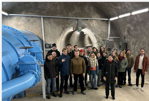
Abb. 2: Exkursion der Studierenden des Studiengangs B.Sc. Ressourcenmanagement Wasser zur Bodenseewasserversorgung.
