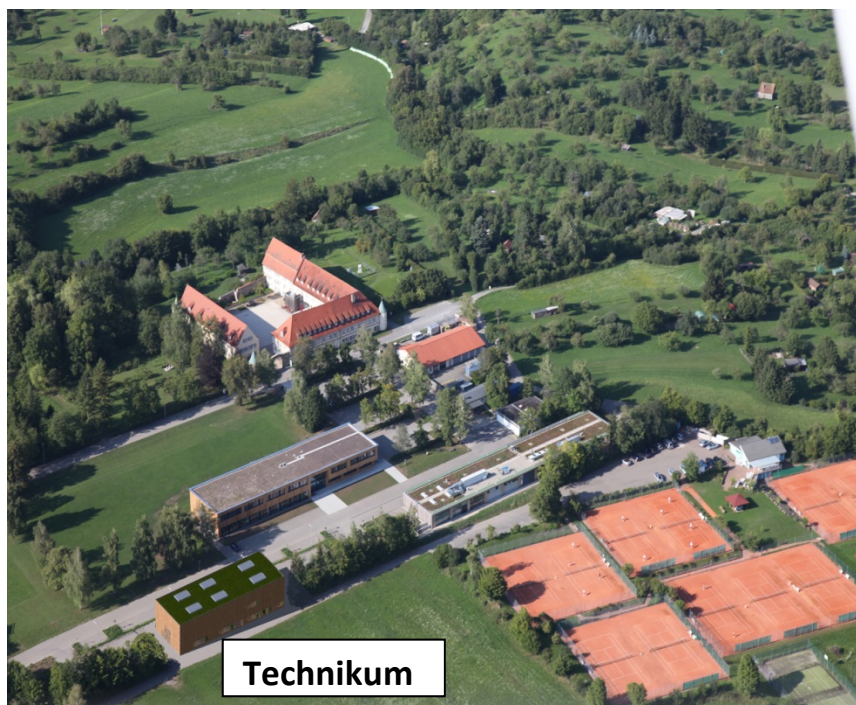
Abb.2: Fotomontage einer Luftaufnahme vom Campus der HFR im Mai 2015 mit dem projektierten Technikum
