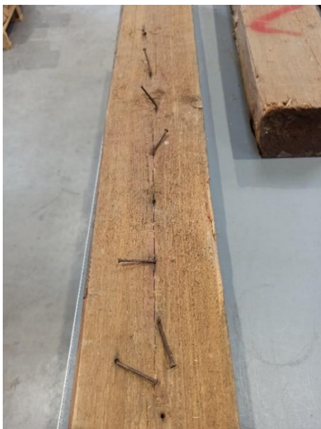
Dachbalken mit zahlreichen Bfm
