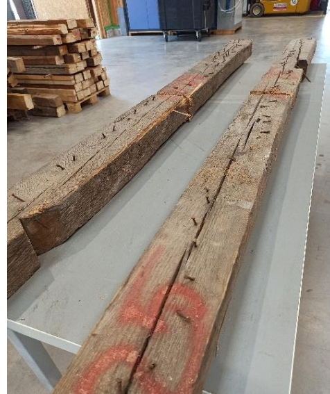
Dachbalken mit Nägeln und Verkämmung
