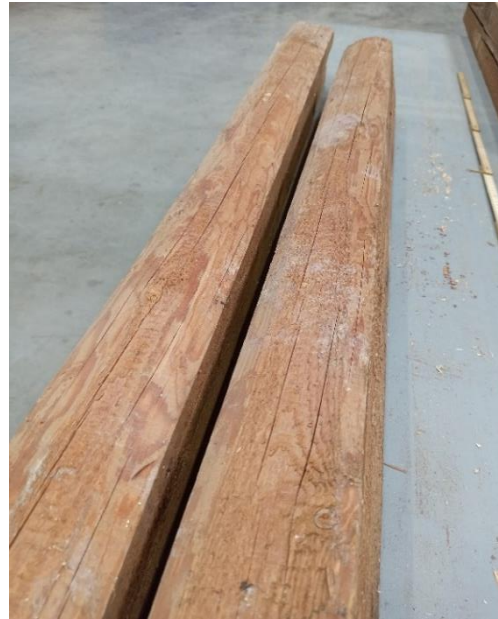
Dachbalken ohne Bfm
