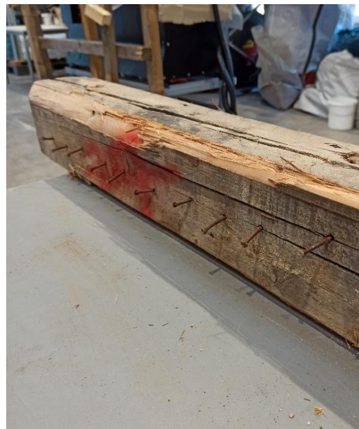
Dachbalken mit zahlreichen Bfm
