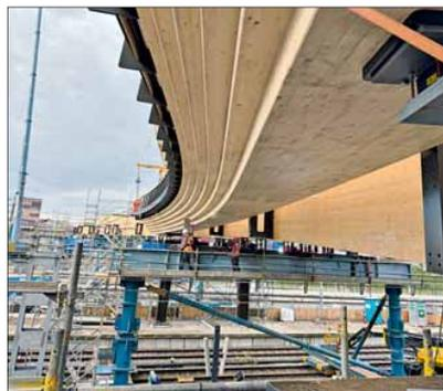
Über zwölf Gleise führt die 130 m lange Fußgänger- und Radfahrer-Brücke in Zwolle. Der Brückenquerschnitt besteht aus vier blockverklebten Brettschichtholz-Trägern, die über Stahlträger gekoppelt sind.
