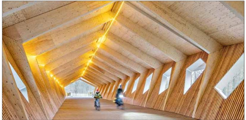
Innenansicht der 67,50 m langen Brücke über den Brüsseler Ring in Tervuren/Belgien, die als polygonale Röhre aus GLVL-Platten ausgebildet und alle 3 m durch Querrippen verstärkt wurde. Die Brücken-„Box“ hält als geschützte Konstruktion sowohl die Konstruktion aus auch die Benutzer trocken.
