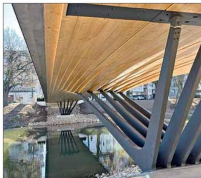
Die 55 m lange Rathausbrücke in Tuttingen ist eine Holz-Beton-Verbund-Konstruktion mit 6 m Breite. Das Rahmentragwerk wird von V-förmigen, in sich aufgelösten Stahlstützen getragen.
